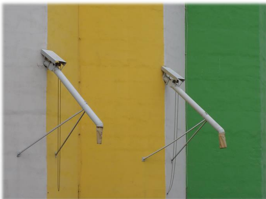
Fotografie č. 43: Detail výpusti sila na zrniny (autoři, 2019)
