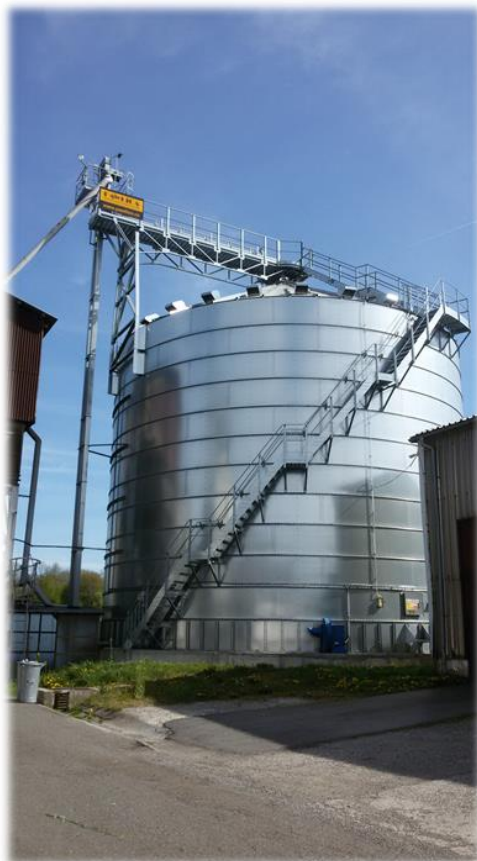
Fotografie č. 40: Silo pro skladování zrnin (objem: 1,5 tisíc tun) (autoři, 2019)
