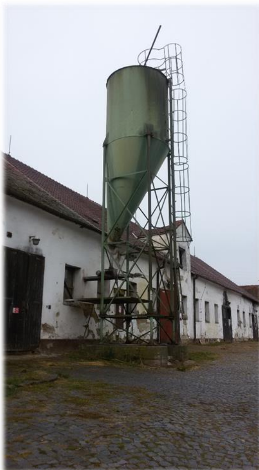
Fotografie č. 65: Silo pro samovolné vyprazdňování doplňkové krmné směsi (autoři, 2019)
