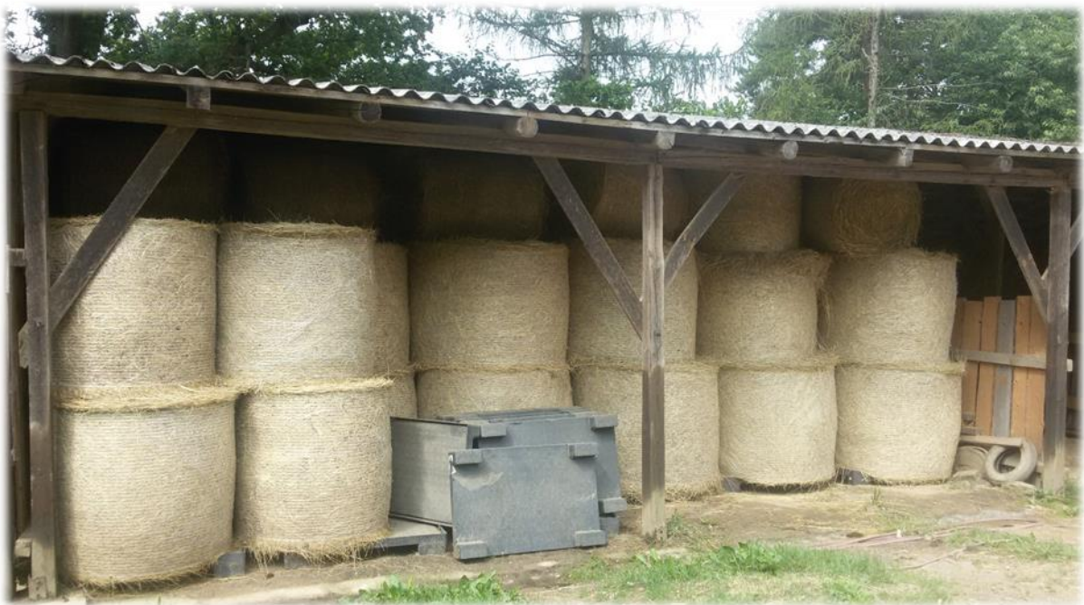
Fotografie č. 11: Uskladnění balíků sena pod střechou ložených na paletách (autoři, 2019)
