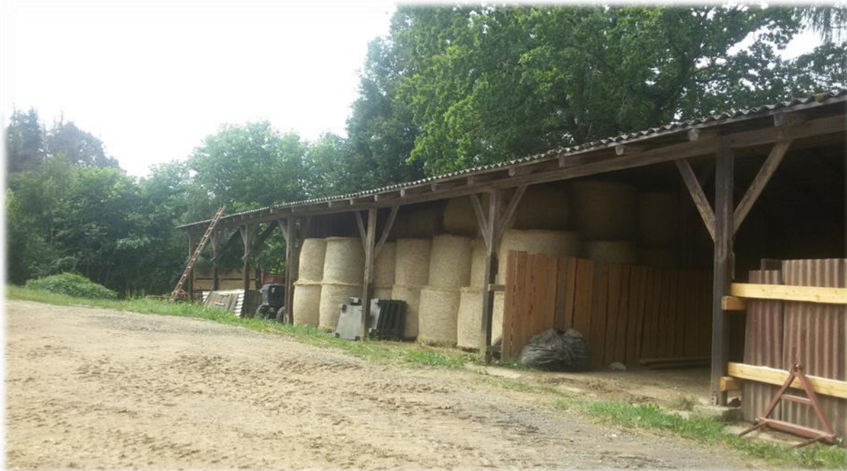
Fotografie č. 10: Uskladnění balíků sena pod střechou (autoři, 2019)
