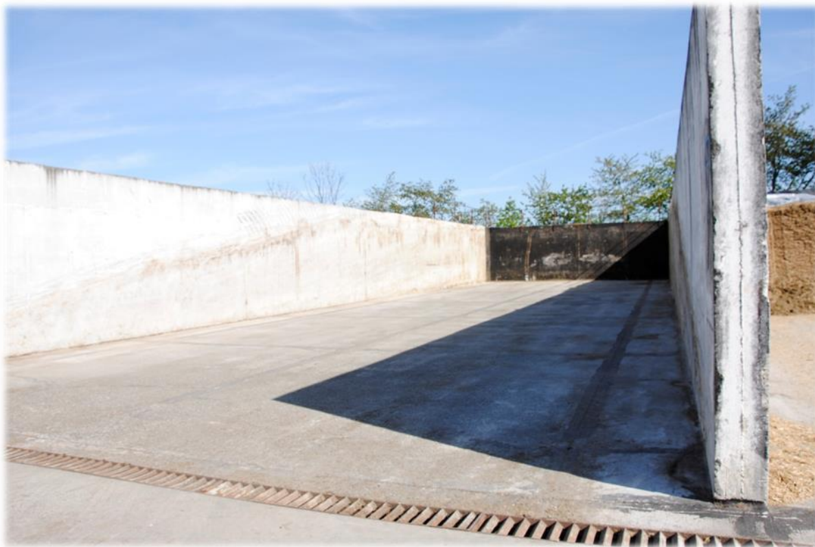
Fotografie č. 28: Prázdná vyčištěná silážní jáma (autoři, 2019)
