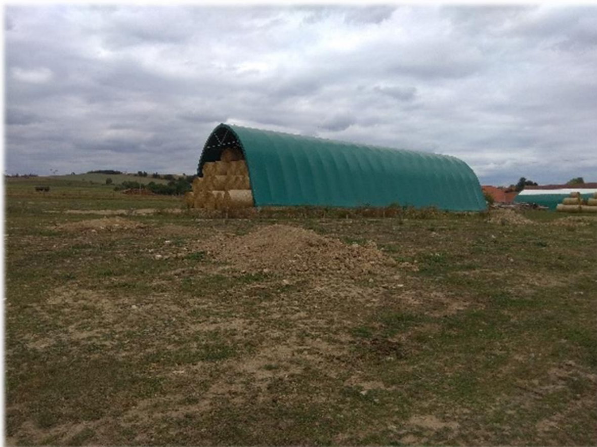
Fotografie č. 9: Boční pohled na skladovací plastovou halu (autoři, 2019)
