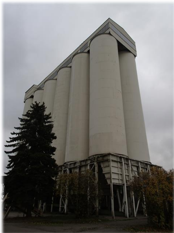
Fotografie č. 41: Silo pro skladování jaderných krmiv (autoři, 2019)
