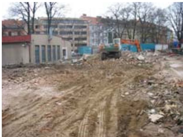
■ Konečná fáze demolicce
