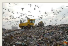
Zhuťování vrstev sklárky pomocí kompaktoru
