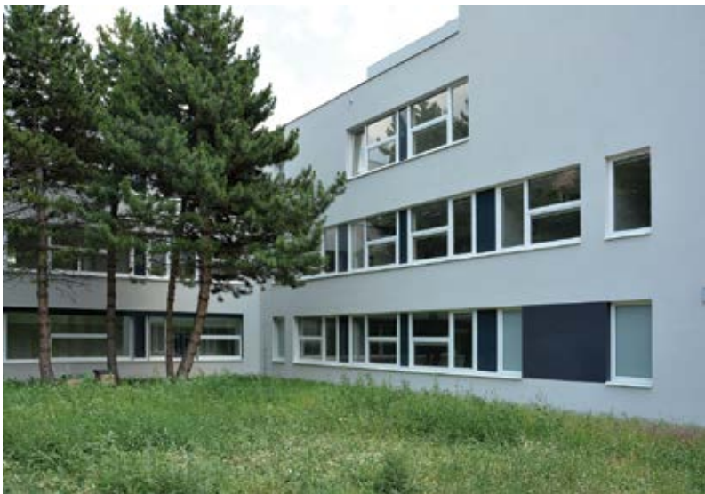
Nově zrekonstruovaná budova 25
