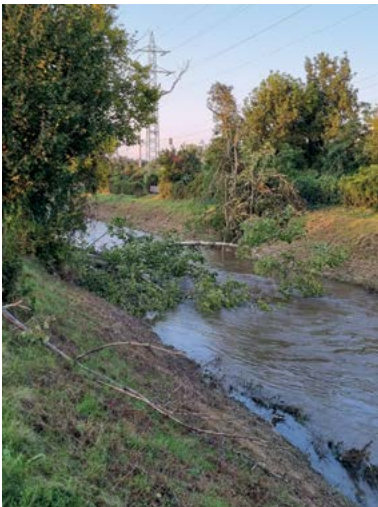
Následky přívalové vlny a vysoké hladiny řeky Svitavy v Brně
