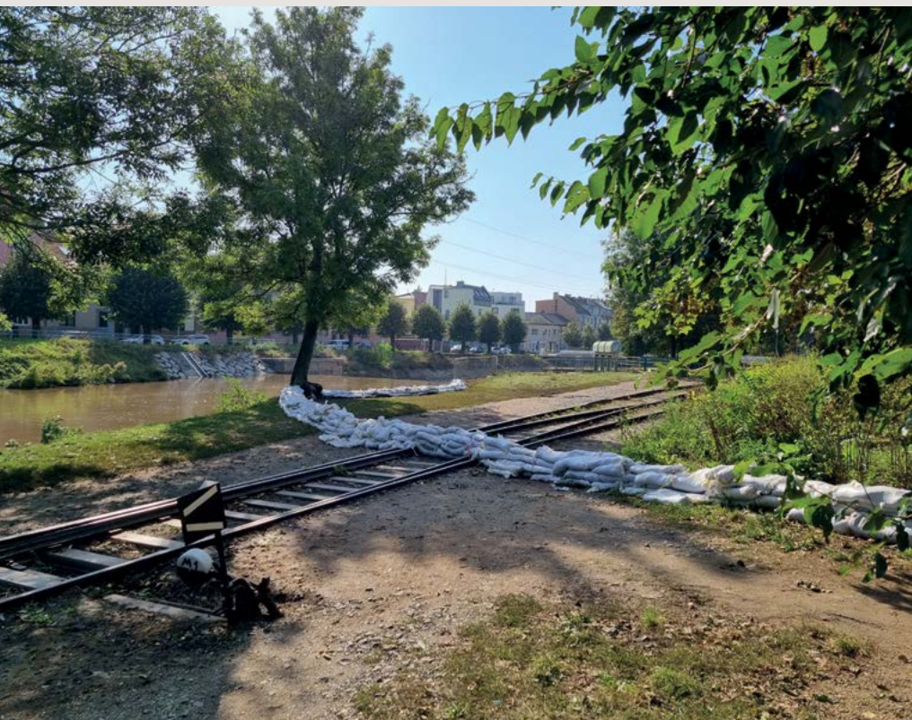
Zábrany v městě Brně u řeky Svitavy proti přívalové vlně a možnému rozlivu řeky
