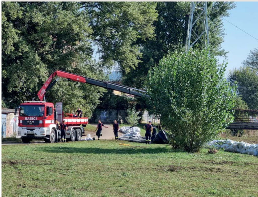
Odstraňování následků přívalové vlny rozvodněné řeky Svitavy v městě Brně
