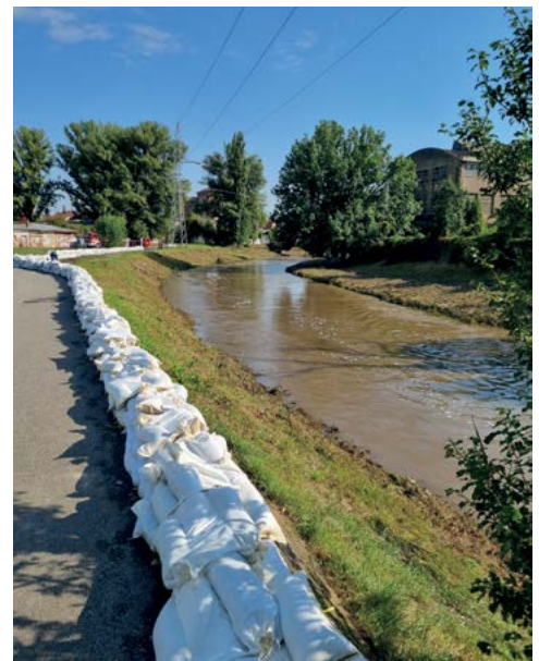
Protipovodňová opatření na řece Svitavě postavená příslušníky záchranných sborů
