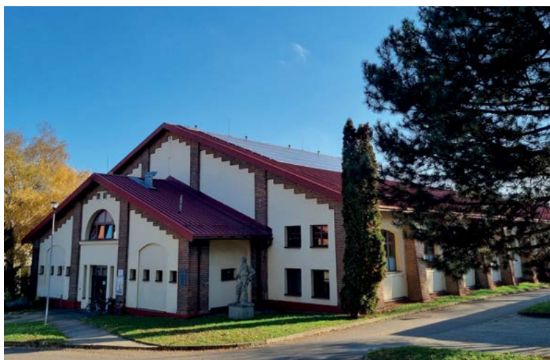
Fotovoltaické panely jsou umístěny také na sportovní hale
