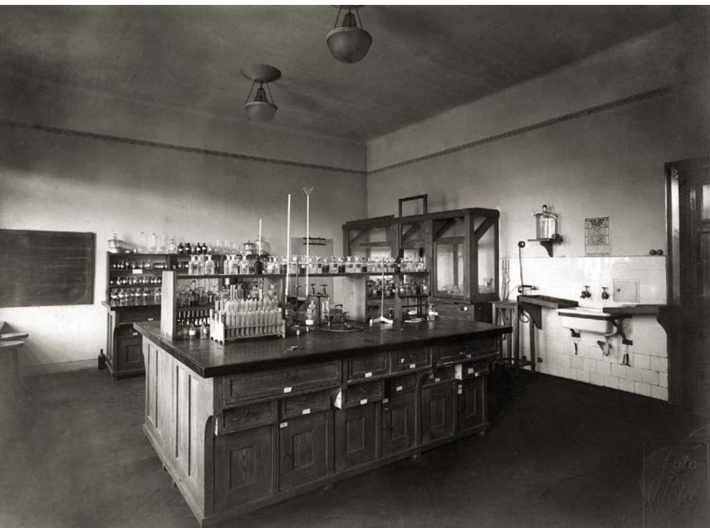
Původní cvičebna v budově 31
