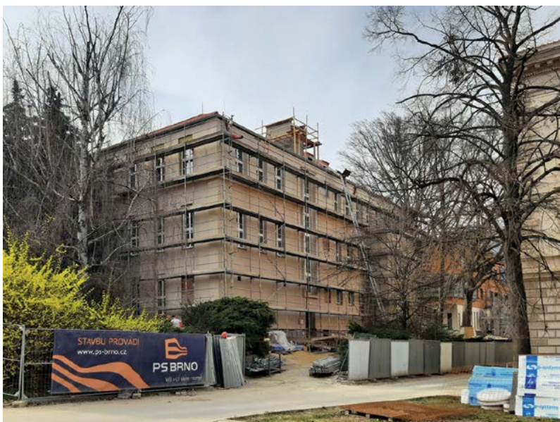
Dokumentace průběhu rekonstrukce budovy 31 v letech 2020/2021
