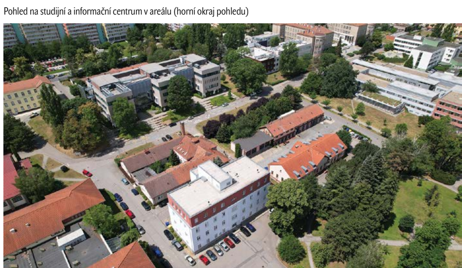
Pohled na studijní a informační centrum v areálu (horní okraj pohledu)
