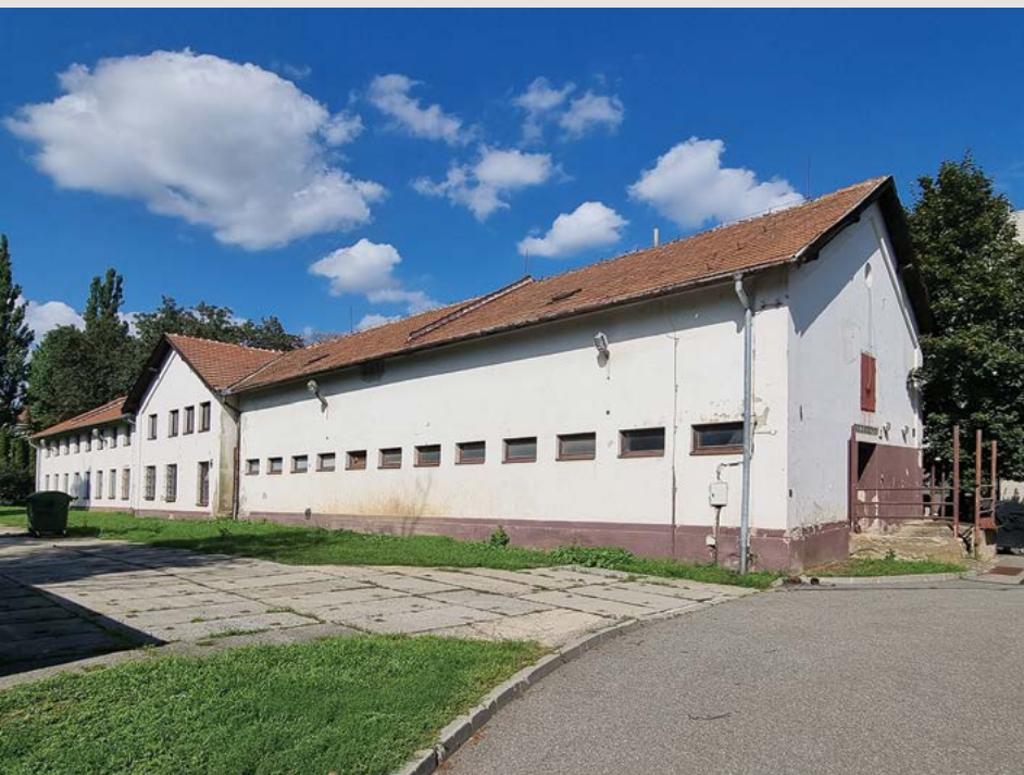
Budova určená k demolici a na jejím místě vybudování dalšího hospodářského zázemí univerzity
