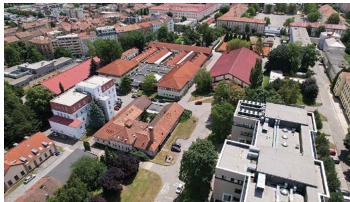
Pohled na jižní část areálu s budovami pro kliniky zaměřené na velká zvířata
