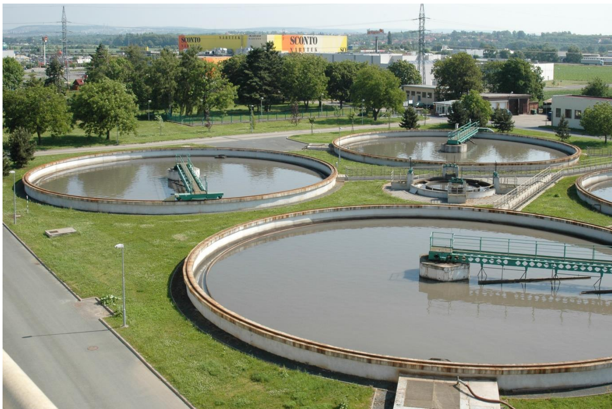
Obr. 11: ČOV Modřice, usazovací nádrže
