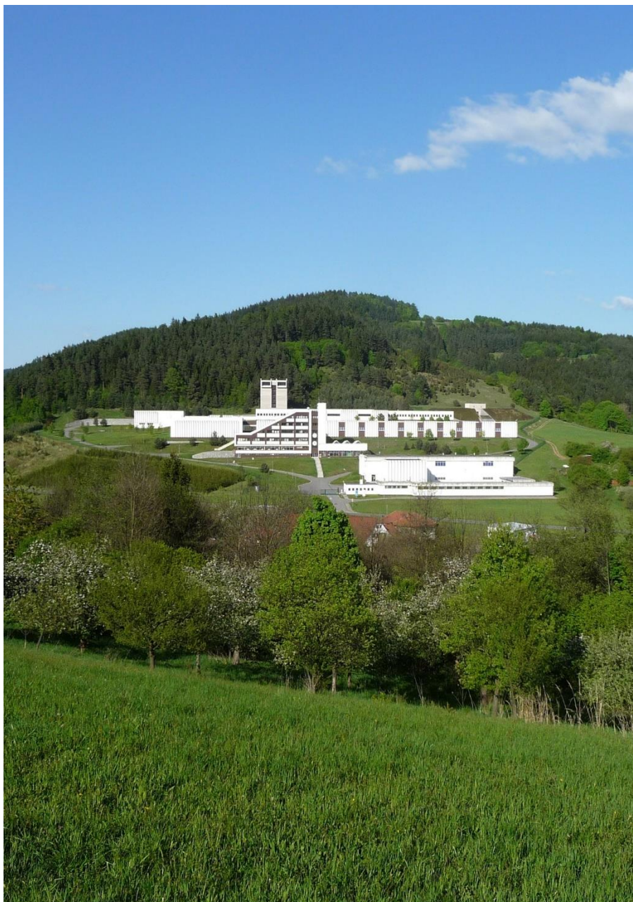
Obr. 18: Úpravna vody Švařec
