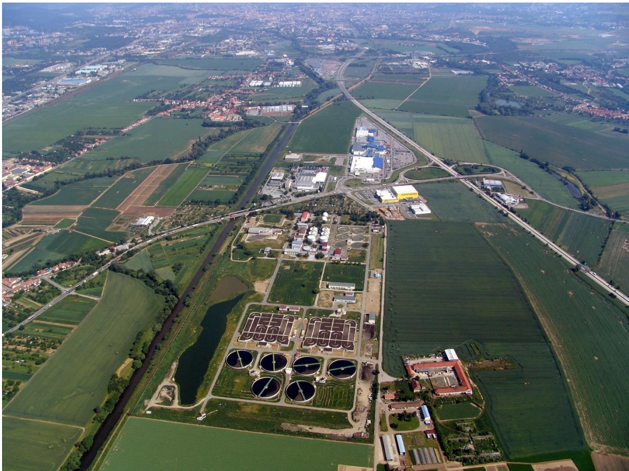
Obr. 9: ČOV Modřice, letecký záběr
