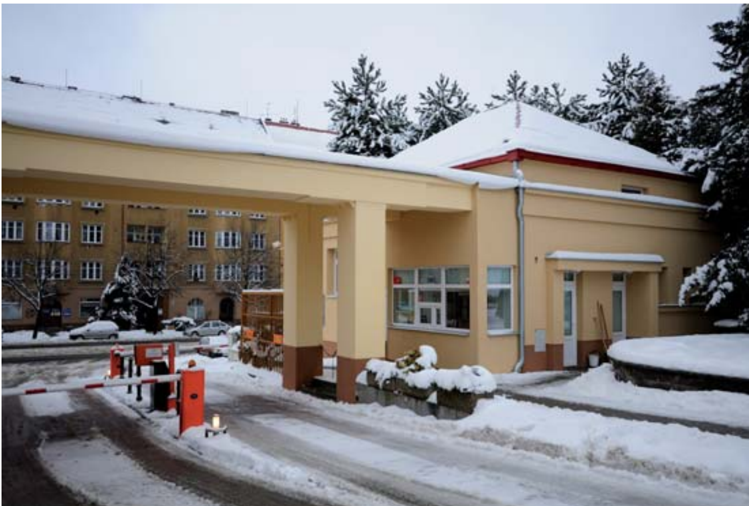
■ Pohled na zrekonstruovanou vrátnici z areálu VFU Brno
