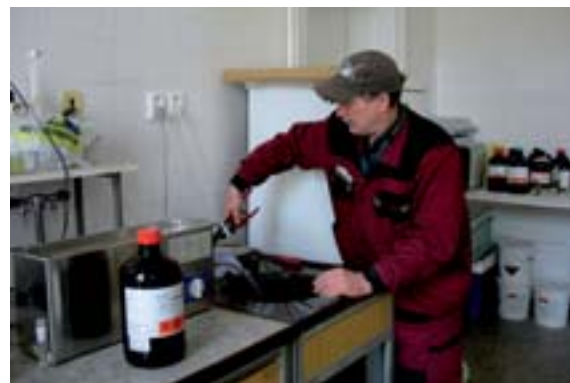
■ Léčitel laboratorních rozvodů, instalatér-topenář Josef Kostečka
