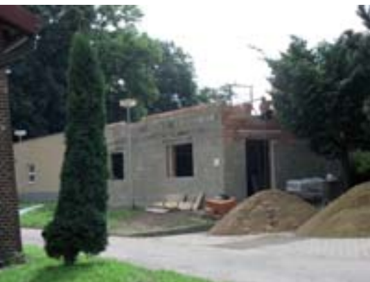
■ Pohled na rozestavěnou stavbu
