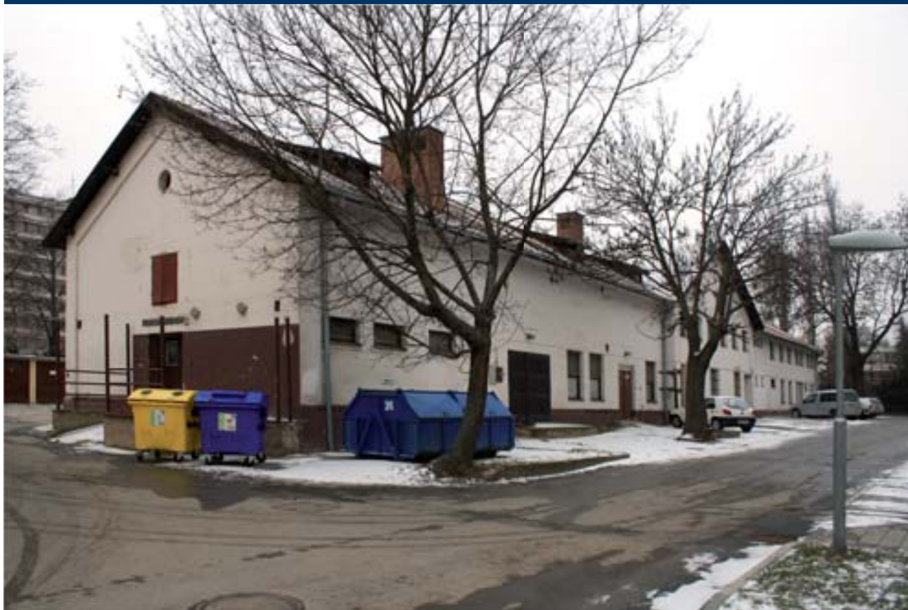
■ Centrum masa a masných výrobků vznikne po přestavbě a rekonstrukci v budově č. 16
