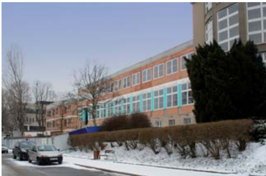
■ Stavební práce na Pavilonu patobiologie budou ukončeny v tomto roce
